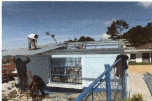
Foto 1: modulo de cocina en proceso de susutitucion de lámina
